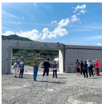
5月26日 ■下船渡地区の防潮堤工事完了、水門陸間の自動閉鎖システムの説明会
